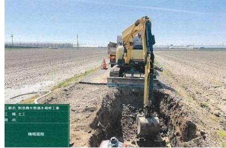
緊急漏水補修工事状況（吉良町地内）
