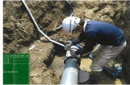
農水管漏水補修工事状況（吉良町地内）
