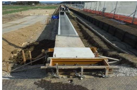
小規模かんがい排水工事状況（下羽角町地内）
