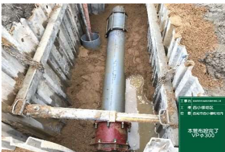
緊急漏水補修工事状況（西小槲町地内）
