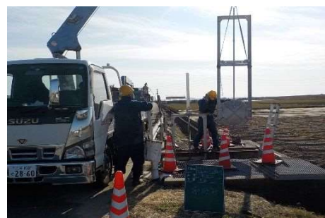
ゲート整備工事状況（奥田町地内）
