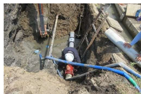
緊急漏水補修工事状況（吉良町荻原地内）
