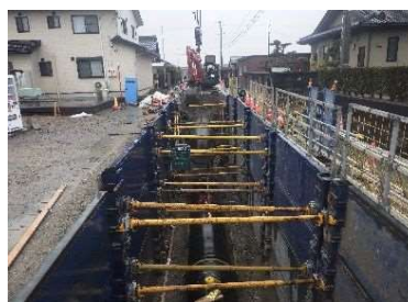
水質保全対策事業 高落4期地区
