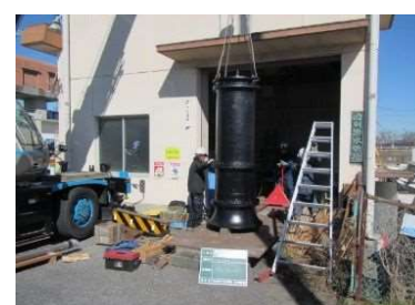
排水施設保全対策事業 治明地区
