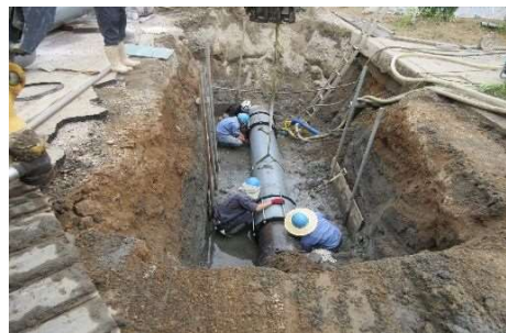
緊急漏水補修工事状況（吉良町富田地内）
