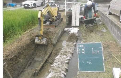
水路補修工事状況（今川町地内）
