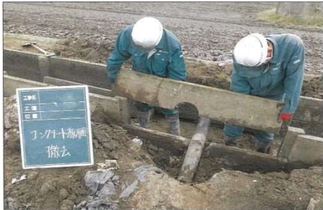
水路補修工事状況（刈宿町地内）
