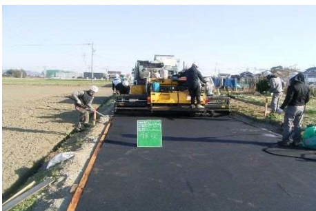
農道舗装工事状況（田貫町地内）
