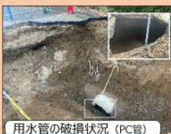
用水管の破損状況（PC管）
