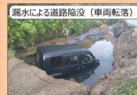
漏水による道路陥没（車両転落）
